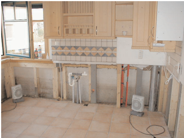
Dämmstoff und Verkleidungsmaterial wurde ca. 30 cm über die Hochwassermarken entfernt, die restliche Kücheneinrichtung kann verbleiben. Ventilatoren beschleunigen die Trocknung
