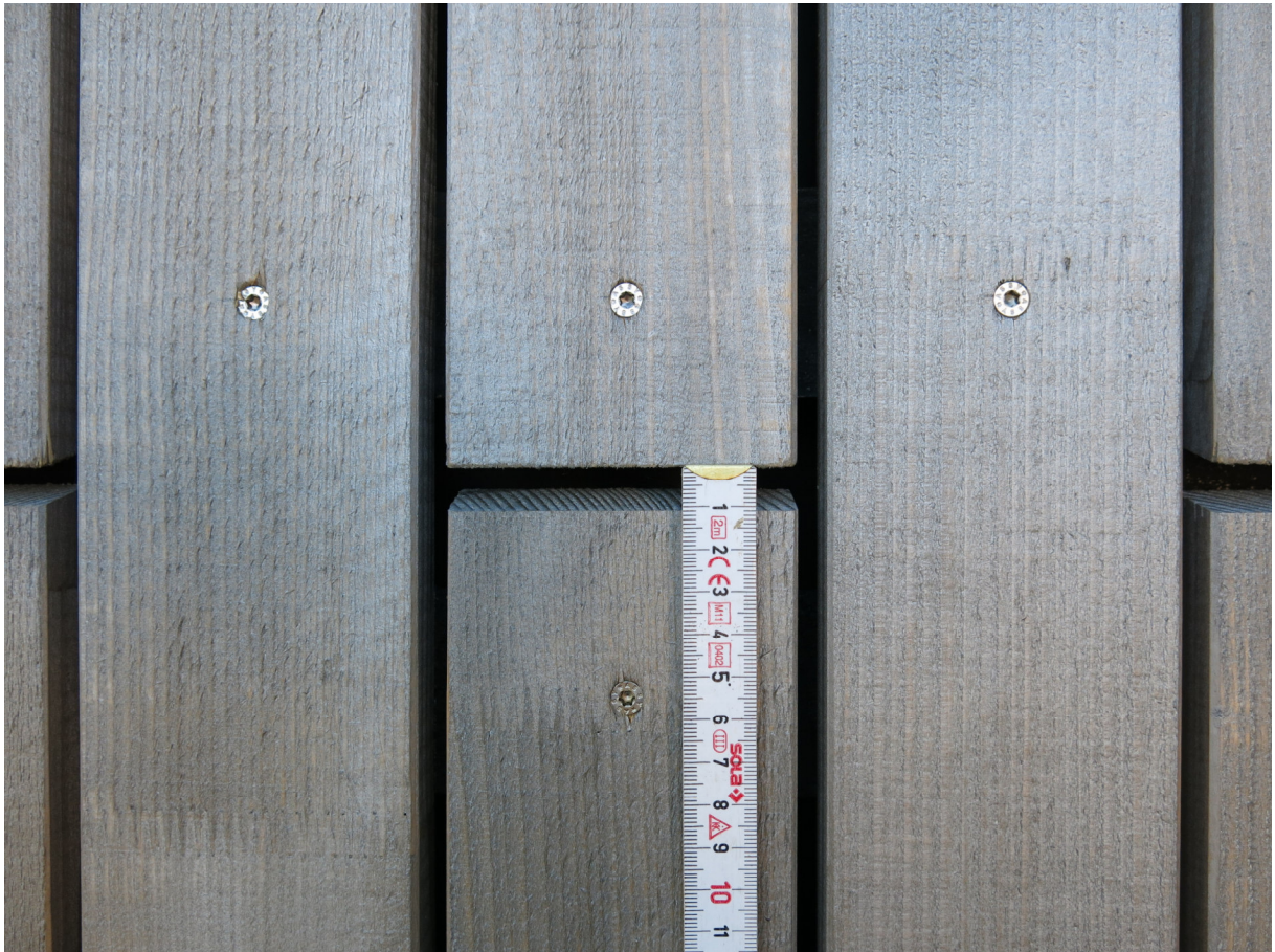
Abbildung 5: Fassade mit offenen Fugen mit ca. 10 mm Breite, in denen die schwarz gestrichen Traglatten nicht erkennbar sind
